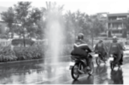
Mỗi khi mưa lớn thường có những tia nước phun mạnh từ các hố ga trên đường Hoàng Sa, Trường Sa và đã có trường hợp hất văng nắp hố ga. Ảnh: MP
