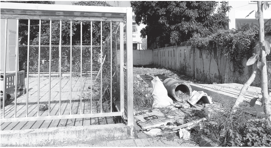
Khu vực thi công cổng ngăn triều. Ảnh: NN
