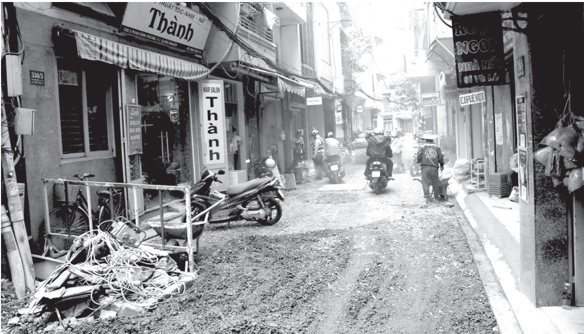
Hẻm 330 đường Phan Đình Phùng, quận Phú Nhuận trước và sau khi được nâng cấp (ảnh nhỏ dưới). Ảnh: NHƯNGỌC
