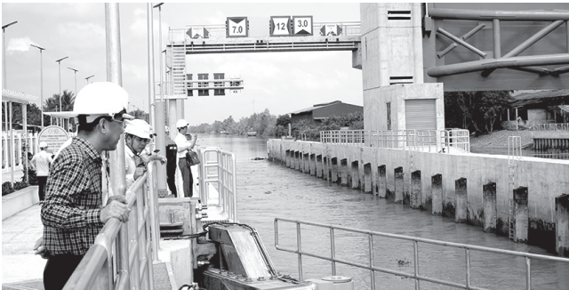
Sau hai năm thi công, công trình cống ngăn mặn lớn thứ hai ở ĐBSCL đã hoàn thành. Ảnh: ĐÔNG HÀ
