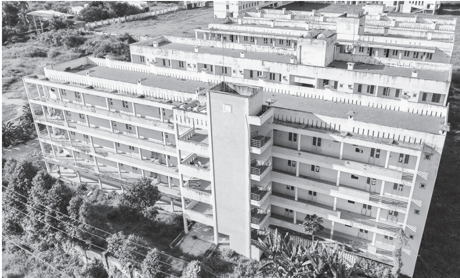
Bốn khối nhà bê thế khu ký túc xá Trường CĐ Y tế Khánh Hòa bỏ hoang bị xuống cấp. Ảnh: XUÂN HOÁT
